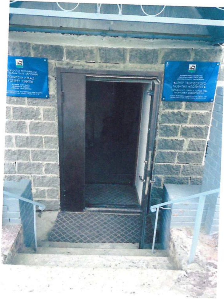
ФОТО № 3, 4: Вход (входы) в здание
